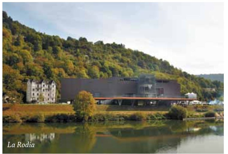
La chaufferie bois du réseau de chaleur
